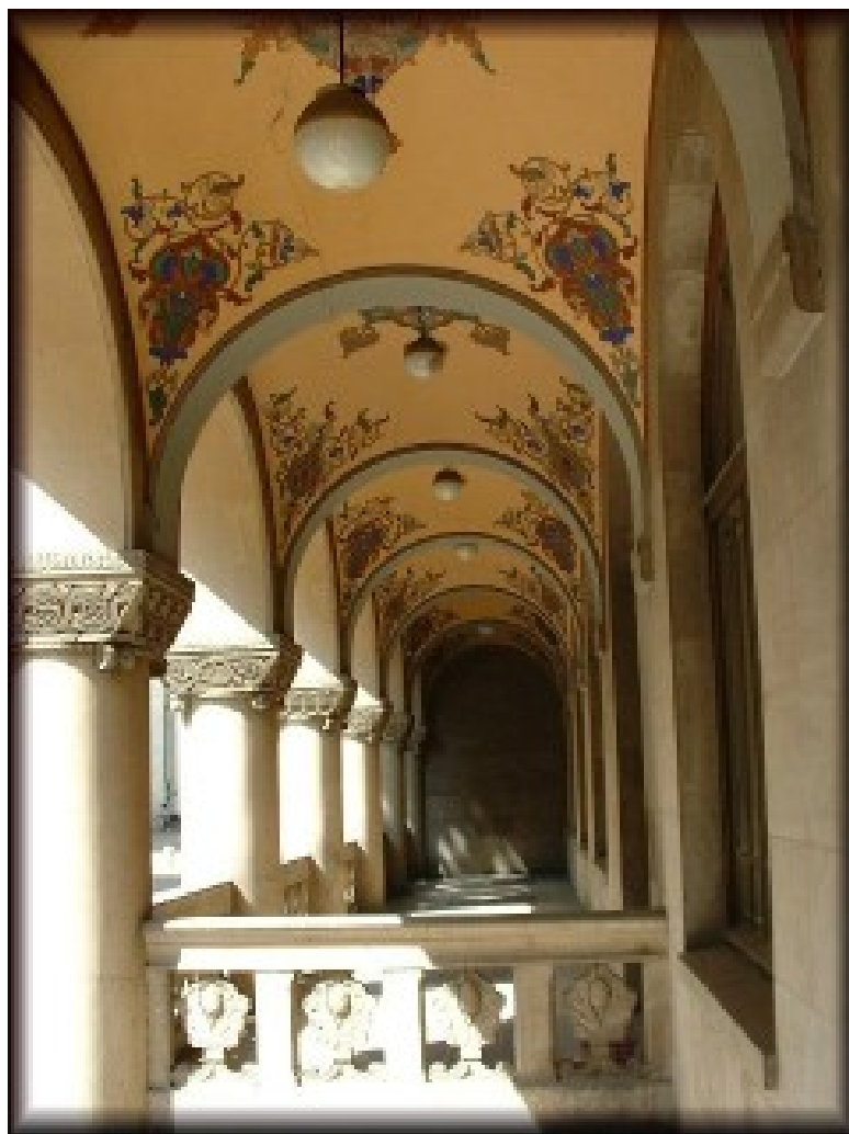
Галерея с парусными сводами
