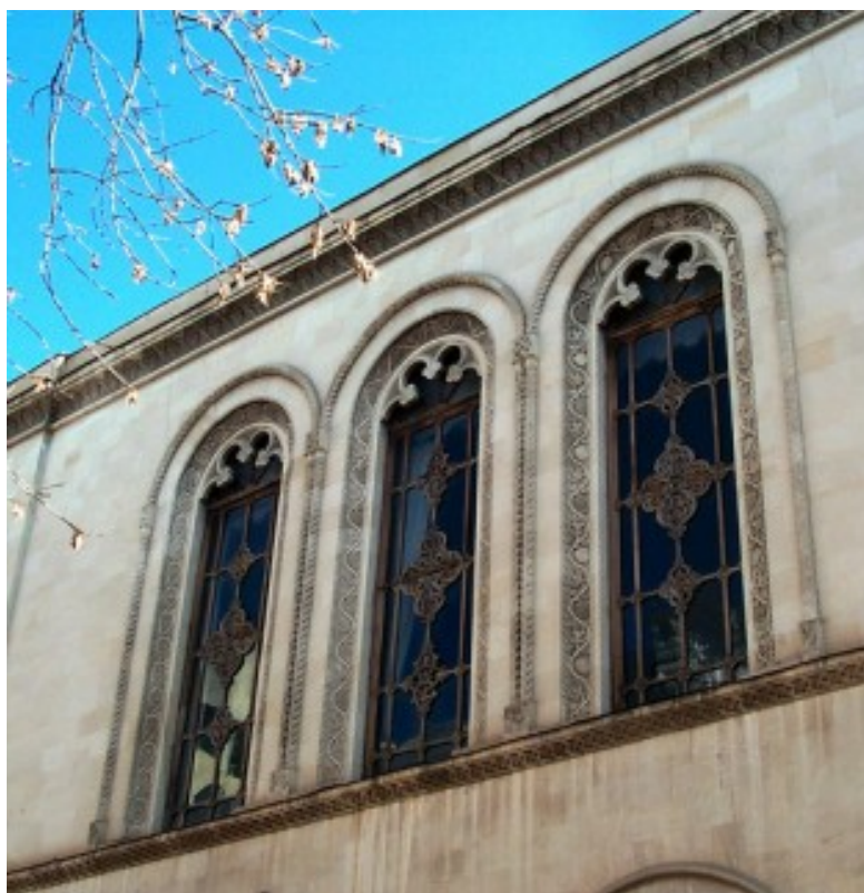
Фрагмент Главного фасада
